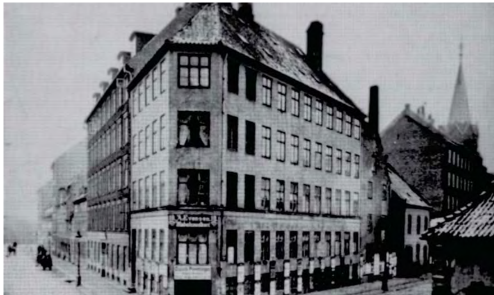
Jónshús við Östervoldgade.
